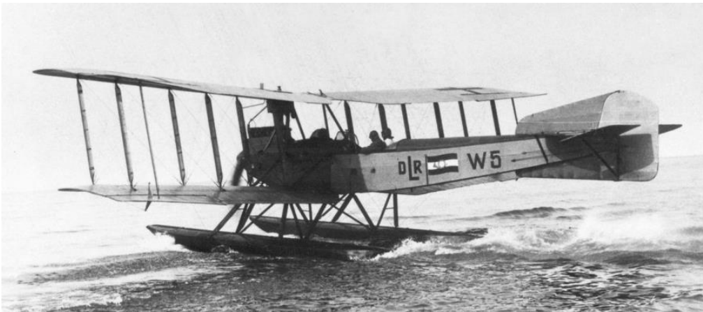
Wasserflugzeug vom Typ Friedrichshafen FF 49 mit der Zulassung DLR W5. Maschinen dieses Typs standen an der Ostseeküste den ganzen Sommer hindurch im Rundflugeinsatz. Die militärischen Kennzeichen waren gelöscht bis auf die Balkenkreuze auf der Flügeloberseite. Auf der Unterseite des unteren Tragdecks trugen die meisten FF 49 den Schriftzug „DLR“ in großen Lettern.
