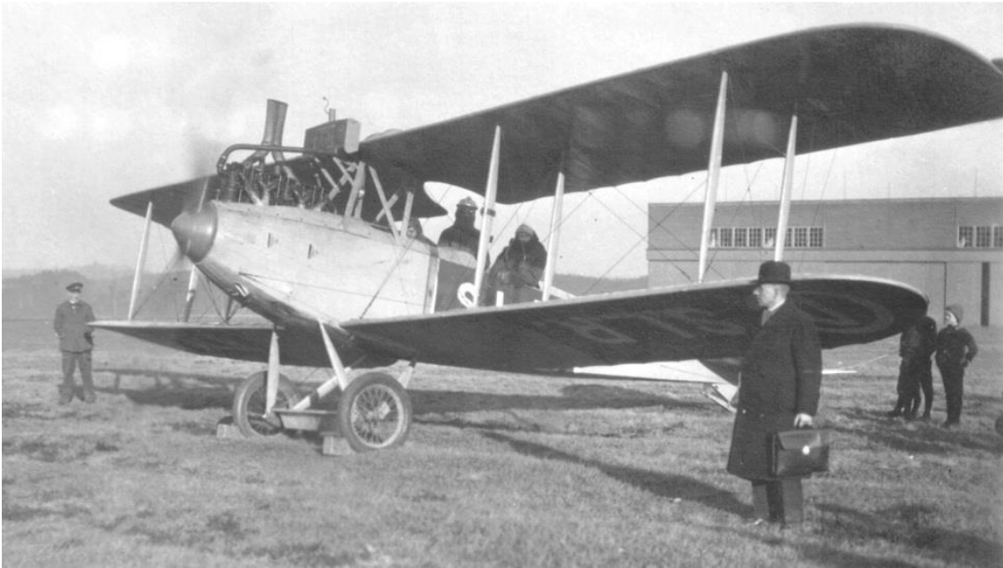
Am Rumpf und unter dem Flügel dieser LVG C V der Sächsischen Luftreederei sind gut die Buchstaben S.L.R. zu erkennen, außerdem unter der Flügelspitze das in einen Kreis gesetzte „D“ als Nationalitätszeichen. Laut Bildunterschrift entstand diese Aufnahme am 8.2.1920 in Zwickau, also zu einem Zeitpunkt als die Kennzeichnung gemäß offizieller Luftfahrzeugrolle A längst vorgeschrieben war. (Slg. Koos/ADL)
