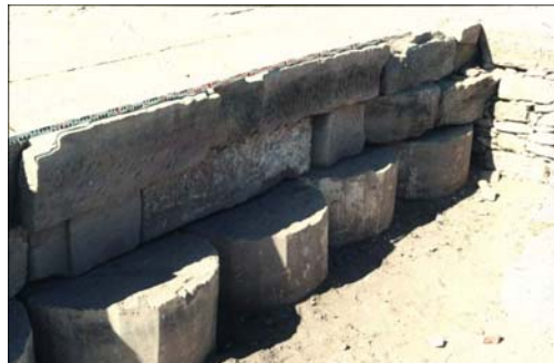
Taf. 18 Säulentrommeln im Fundament des römischen Chnumtempelhofes
