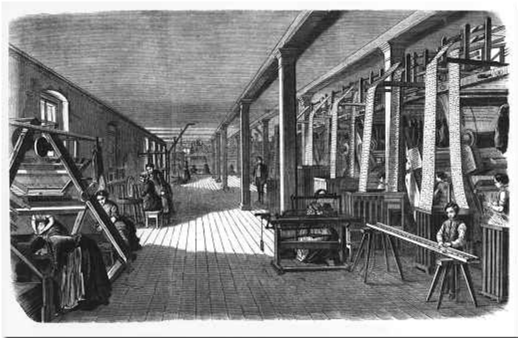
Abb. 10.2 Jacquard'sche Musterwebstühle in der Fabrik Gevers & Schmidt in Schmiedeberg (Schlesien), Holzstich von 1858
