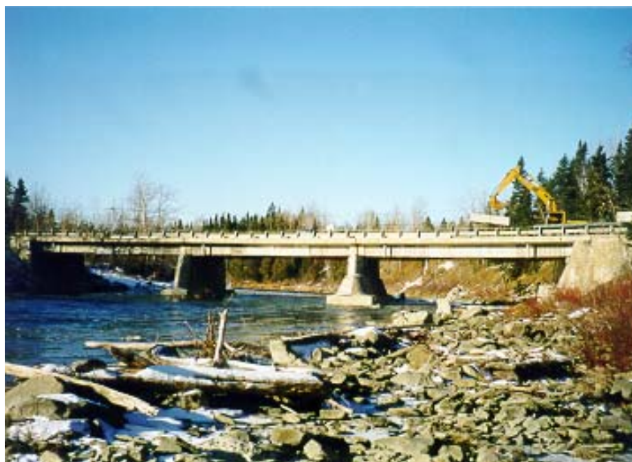
Figure 10 : Photo du pont en béton armé de 4 poutres
