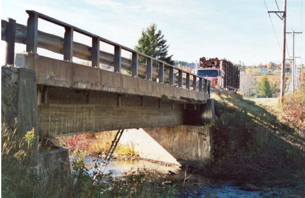
Figure 12 : Photo du pont en béton armé de 2 poutres
