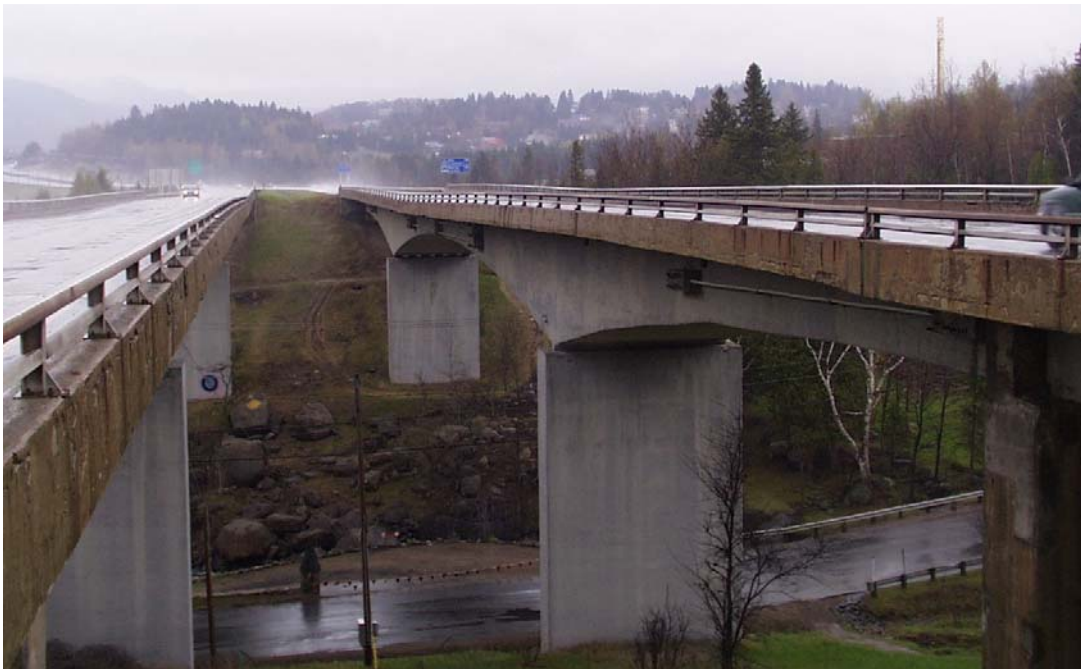
Figure 16 : Pont à poutre caisson en béton précontraint 2
