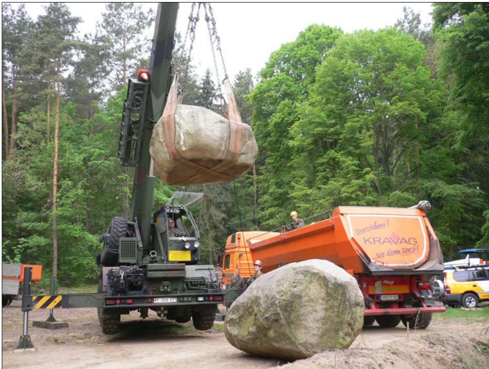
Schweres Gerät hilft bei der Gestaltung des Findlingsgartens.
