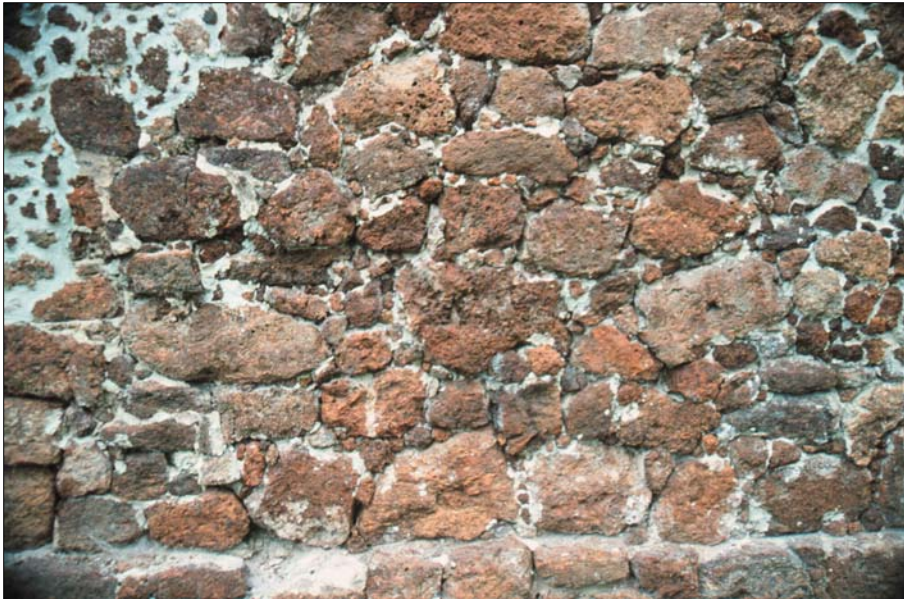
Mauerwerk aus Raseneisenstein
