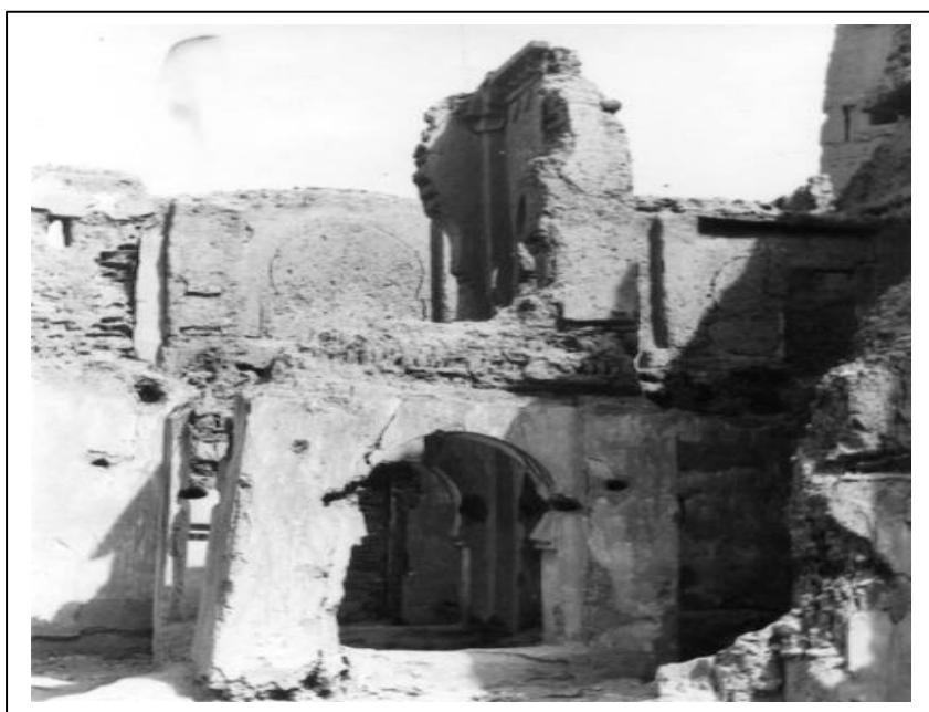
Photo n°12: Bâtiment en ruine après son abandon.
