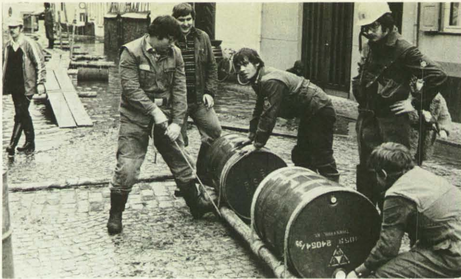
Helfer des Technischen Hilfswerks bauten in Braubach am Rhein einen Steg.
