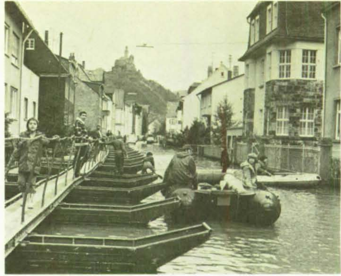
Soldaten des Pionierbataillons 5 aus Lahnstein errichteten einen Pontonsteg in einer Straße von Braubach am Rhein.
