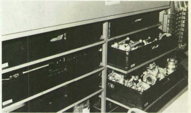
Bild 4: Palettenschrank für Feuerlöscharmaturen, Chemikalien, Leuchten und Kleingeräte.
