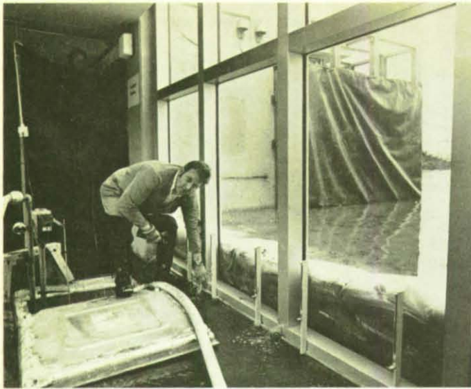
Vor den Fenstern des Bundeshauses in Bonn schwappte das Rheinhochwasser. Obwohl Sandsäcke und Stahlwände die Flut dämmen sollten, strömte Wasser in das Gebäude.
