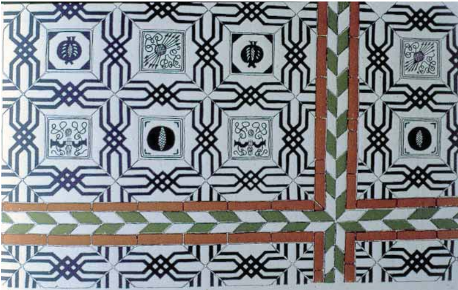
24. Detalle de la solería del Salón del Trono, La Aljafería de Zaragoza, 1492-1495 (reconstrucción de M. González Martí).
