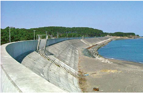
日本修建的带有疏散阶梯的海堤，用以保护沿海城镇免于海啸淹没。图片由日本国土交通省河川局提供。
