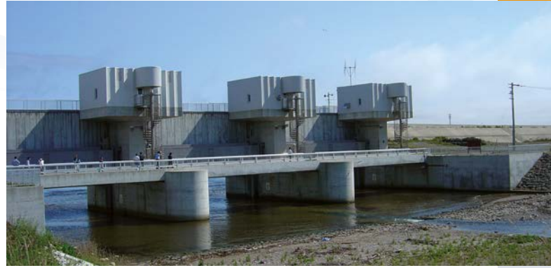
日本奥尻岛阻挡海啸波的水闸。地震震动触发振动传感器后几秒钟内水闸即开始自动关闭。图片由国际海啸信息中心提供。
