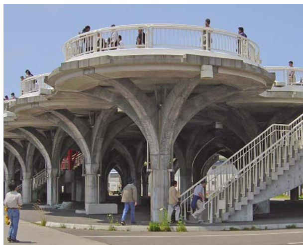
日本奥尻岛用于海啸疏散的高台，高台也作为旅游观光台使用。图片由国际海啸信息中心提供。
