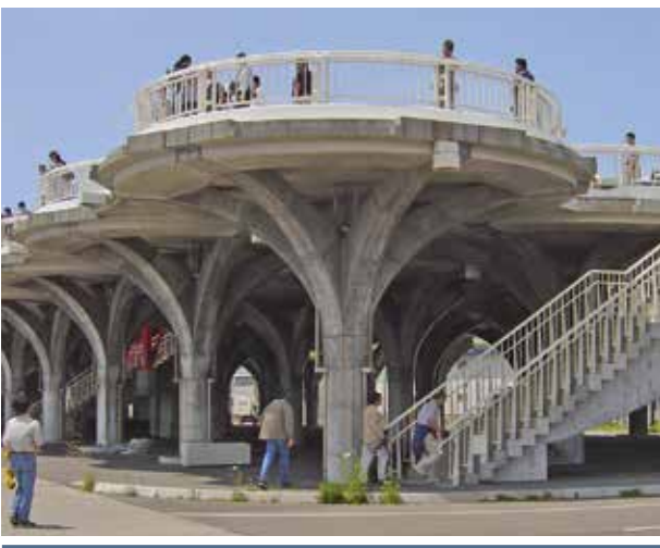
Plate-forme surélevée utilisée pour l'évacuation lors d'un tsunami, et qui sert aussi de point de vue pour les touristes. Île d'Okushiri, au Japon. Crédit photographique : CIIT.
