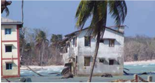
Le séisme du 26 décembre 2004 s'est traduit par une subsidence terrestre de 1,2 m à Car Nicobar, dans les îles Nicobar, en Inde. Des maisons, jadis au-dessus du niveau de la mer, baignent à présent dans l'eau. Crédit photographique : ICMAM, Chennai, DOD, Inde
