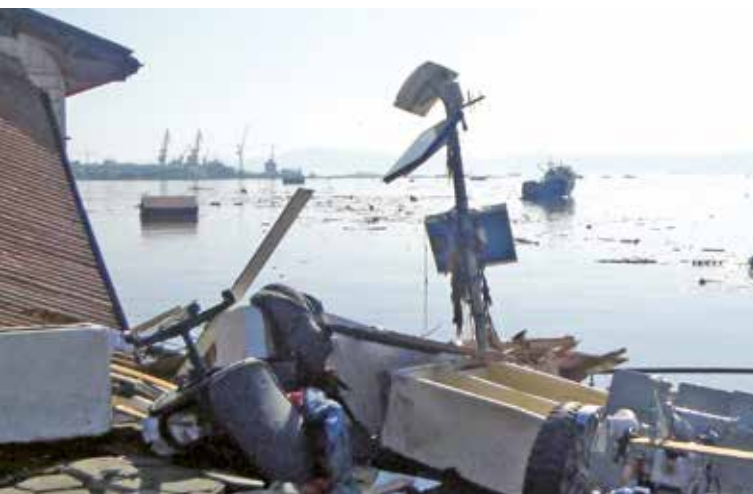
Los tsunamis pueden dañar las instalaciones costeras. Este mareógrafo en Talcahuano fue usado por la Marina chilena para vigilar el tsunami del 27 de febrero de 2010 que azotó Chile. Durante el tsunami del 11 de marzo de 2011 en Japón, siete estaciones fueron destruidas o dañadas y seis dejaron de transmitir datos dejando al JMA sin capacidad para vigilar la severidad del tsunami. Fotografía por cortesía de R. Núñez Gundlach.
