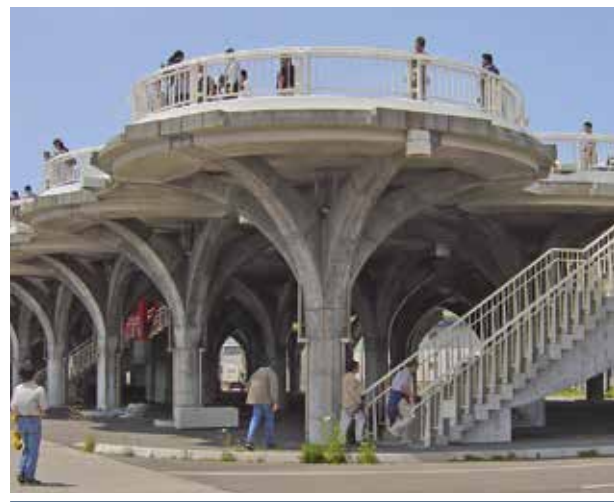
Plataforma elevada utilizada como mirador turístico y para la evacuación en caso de tsunamis, isla de Okushiri (Japón). Fotografía por cortesía del ITIC.
