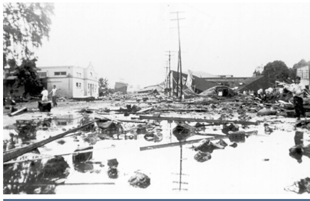
Destrucción en los muelles de Hilo (Hawái) ocasionada por el tsunami transpacífico generado mar adentro de la isla de Unimak (islas Aleutianas, EE.UU.) el 1 de abril de 1946.
