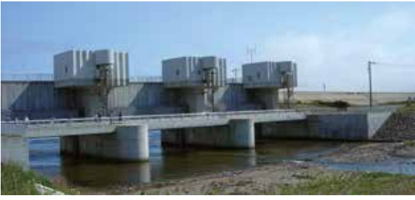
Esclusa usada como protección contra las ondas de tsunami en la isla de Okushiri (Japón). La compuerta comienza a cerrarse automáticamente unos segundos después de que el movimiento telúrico active los sensores sísmicos. Fotografía por cortesía del ITIC.
