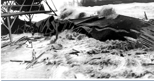
Dstrucción de la bahía de Hilo (Hawái) causada por el tsunami generado frente a las costas de la isla Unimak de las islas Aleutianas (EE.UU.) el 1 de abril de 1946 que llegó a las costas de Hawái en menos de cinco horas. Fotografía por cortesía de la NOAA.
