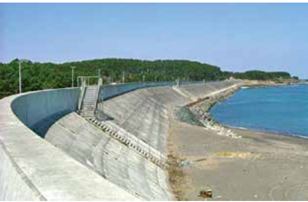
Barrera de contención, con escaleras como ruta de evacuación, usada para proteger un pueblo costero contra la inundación por tsunami en Japón. Fotografía por cortesía de la Oficina de Ríos, Ministerio de Tierra, Infraestructura y Transporte de Japón.
