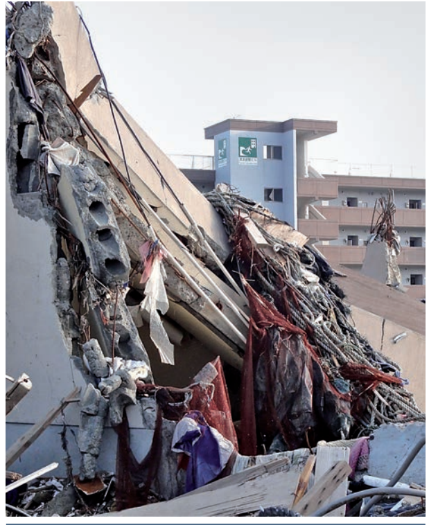
مبان عالية بالخرسانة المسلحة استُخدمت ملاجئ للإجلاء وفق مسار شاقولي إبان حالة أمواج التسونامي التي ضربت اليابان في ١١ آذار/مارس ٢٠١١، ما أنقذ حياة كثير من الناس (مينايمي سانريكو في اليابان). تُستخدم هذه الصورة بإذن من المركز الدولي للإعلام عن أمواج التسونامي (ITIC).
