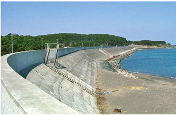
日本修建的带有疏散阶梯的海堤，用以保护沿海城镇免于海啸淹没。图片由日本国土交通省河川局提供。
