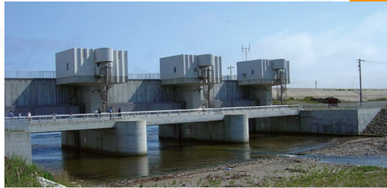
日本奥尻岛阻挡海啸波的水闸。地震震动触发振动传感器后几秒钟内水闸即开始自动关闭。图片由国际海啸信息中心提供。
