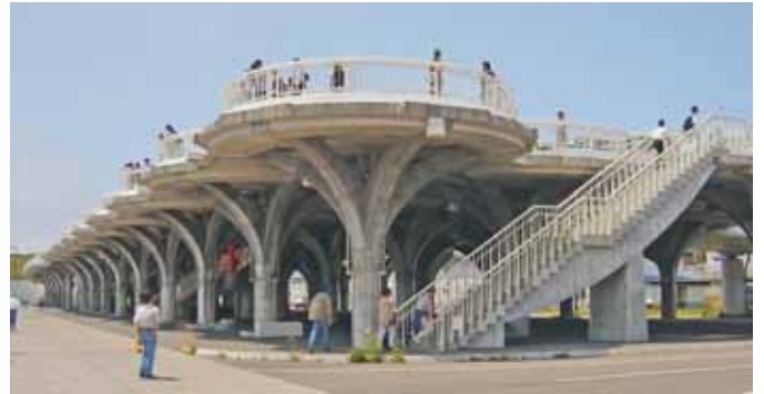
Plateforme surélevée utilisée pour la mise à l'abri de la population et qui sert en même temps de point de vue touristique sur l'île d'Okushiri au Japon. Photo CIIT.
