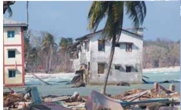
Le séisme du 26 décembre 2004 provoqua une subsidence de 1,2m à Car Nicobar, dans les îles Nicobar. L'indé a laissé des maisons qui étaient en dessous du niveau de la mer et sont maintenant submergées de façon permanente.
