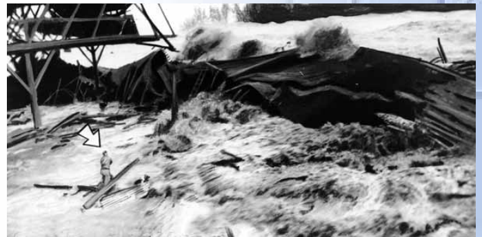
Destruction du port d'Hilo (Hawaii) le 1er avril 1946. Le tsunami induit par un séisme de subduction au large de l'île d'Unimak aux îles Aléoutiennes, a traversé tout le Pacifique, atteignant les côtes d'Hawaii en moins de cinq heures. Photo de la NOAA.
