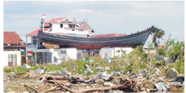
Les run-up peuvent souvent être déduits de l'extension verticale de la végétation détruite, de débris situés en temps normal sur le sol et retrouvés accrochés à des lignes électriques, dans les arbres, ou à d'autres hauteurs ; et des marques laissées par l'eau le long des murs de construction. Dans des cas extrêmes, des voitures, des bateaux, et d'autres objets lourds ont été déplacés et déposés en haut de constructions. Banda Aceh, tsunami du 26 décembre 2004. Photo de C. Courteny, Tetra Tech EMI.
