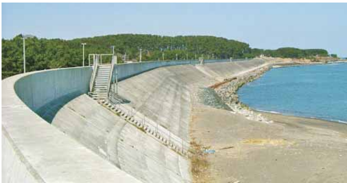
Mur de protection avec des escaliers d'évacuation implanté pour protéger une ville côtière japonaise contre l'inondation des tsunamis. Photo du River bureau, Ministère de de l'Infrastructure et du Transport, Japon.
