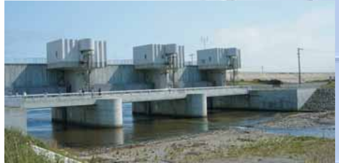
Porte d'eau de protection contre les tsunamis dans l'île d'Okushiri au Japon. Les portes se ferment quelques secondes après la détection des ondes par des capteurs sismiques. Photo CIIT.
