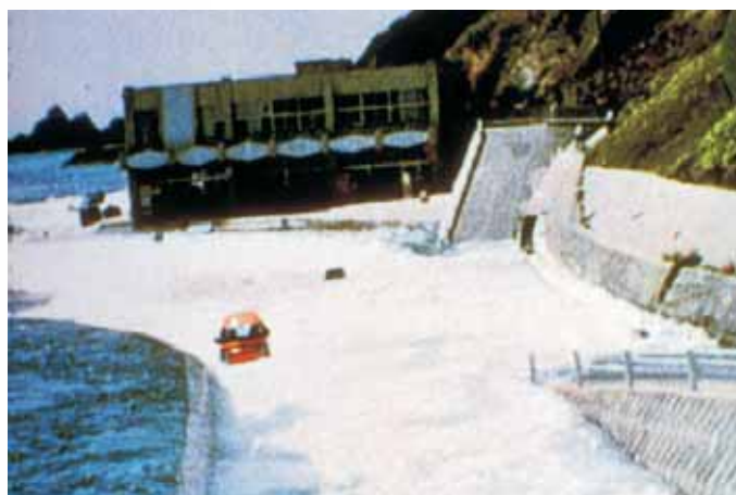
Inondation du tsunami induit par le séisme du 26 mai 1983, à l'aquarium d'Oga au Japon. Photo de Taaki Uda. Public Works Research Institute.
