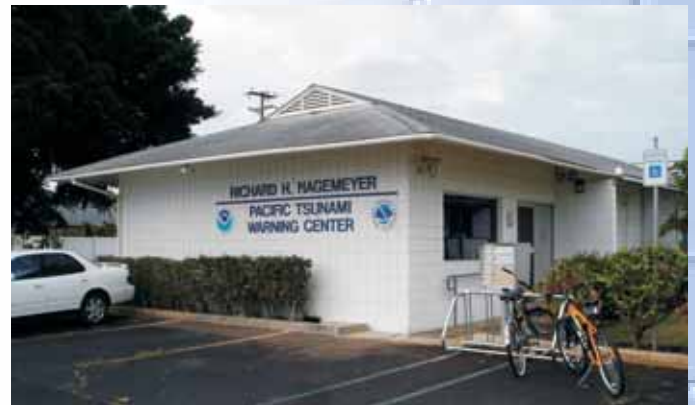
Installations du Centre d'alerte aux tsunamis du Pacifique d'Ewa Beach, Hawaï. PTWC à Ewa Beach, Hawaï, États-Unis.
