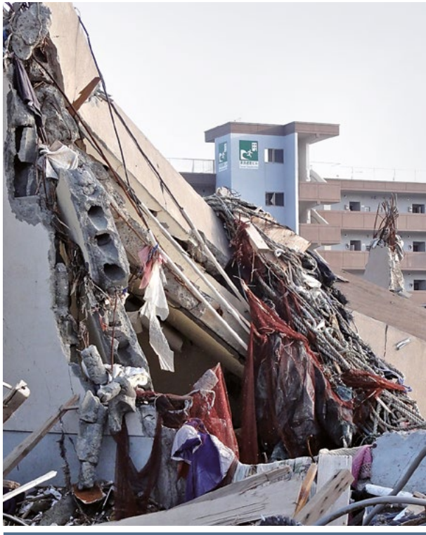
De hauts bâtiments en béton armé ont servi de refuge pour une évacuation en hauteur lors du tsunami survenu au Japon le 11 mars 2011, sauvant ainsi de nombreuses vies. Minami Sanriku, Japon. Crédit photographique : CIIT
