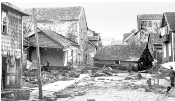
Dégâts causés par le tsunami qui a frappé le Chili le 22 mai 1960. Crédit photographique : Ilustre Municipalidad de Maullin, USGS Circular 1187
