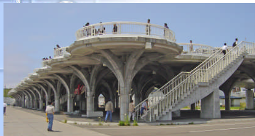
Landasan yang ditinggikan, digunakan untuk evakuasi tsunami yang juga berfungsi untuk titik pemandangan tempat tinggi bagi pelancong. Pulau Okushiri, Jepang. Foto milik ITIC.
