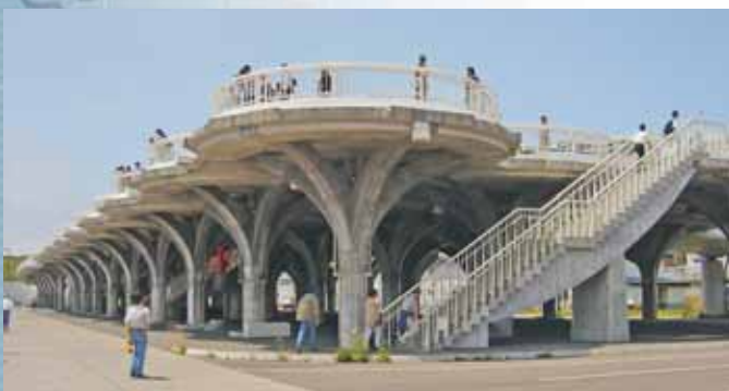
Plataforma elevada utilizada para la evacuación ante un tsunami y también usada como mirador turístico, isla Okishiri, Japón. Fotografía cortesía del ITIC.
