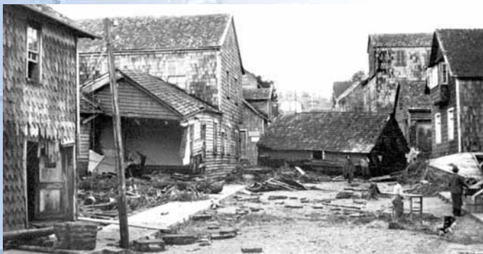
Daños causados por el tsunami en Chile, 22 de mayo, 1960. Fotografía cortesía de la Ilustre Municipalidad de Maullín, Circular 1187 USGS.
