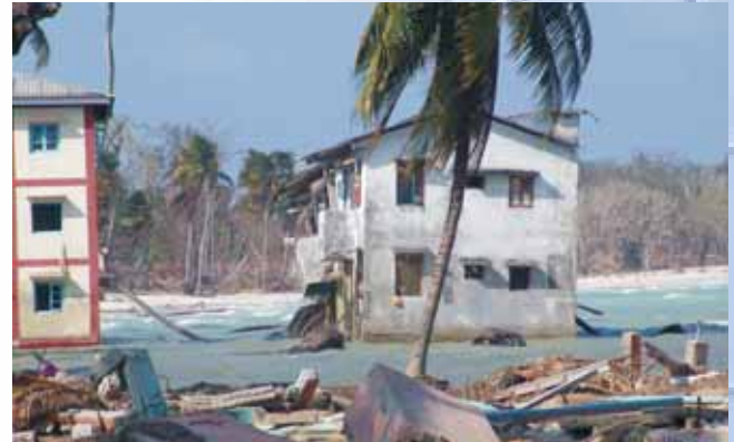
El terremoto del 26 de diciembre de 2004 generó un hundimiento de 1,2 m en Car Nicobar, islas Nicobar, India, dejando viviendas que estaban sobre el nivel del mar permanentemente sumergidas. Fotografía cortesía de ICMAM, Chennai, DOD, India.
