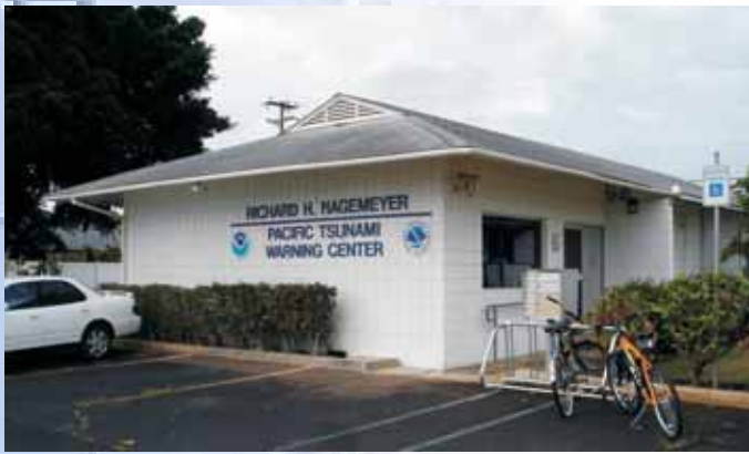
Instalaciones del Centro de Alarma de Tsunamis del Pacífico (PTWC) localizadas en Ewa Beach, Hawaii, EE.UU.
