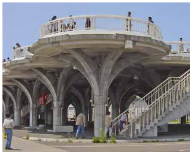
Plataforma elevada utilizada como mirador turístico y para la evacuación en caso de tsunami, isla de Okushiri (Japón). Fotografía por cortesía del ITIC.
