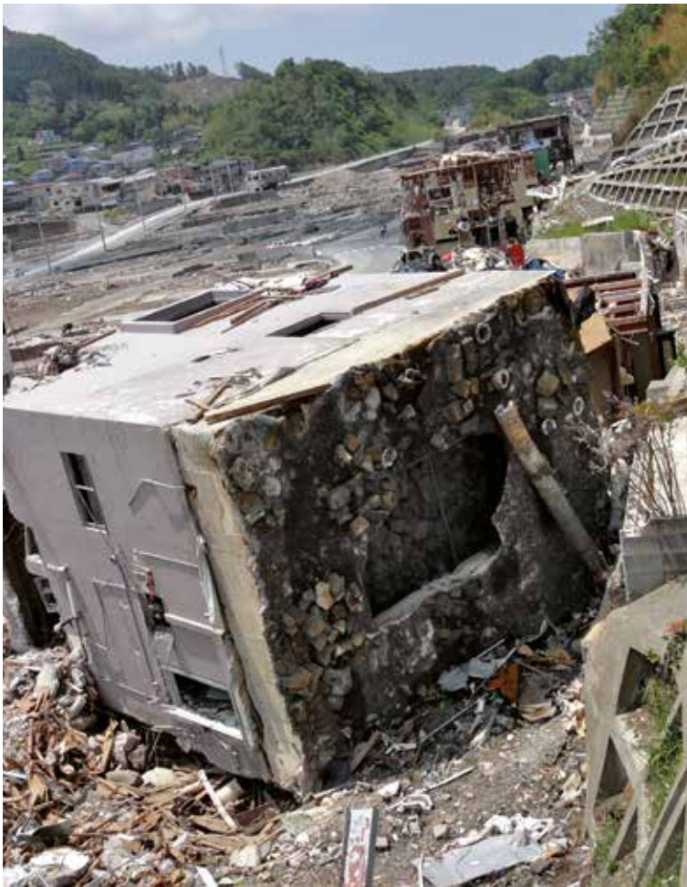
Durante el tsunami de Japón del 11 de marzo de 2011, olas con una profundidad superior a los 10 m alcanzaron una velocidad de 6 m por segundo derribando y arrastrando edificios de tres plantas a casi 50 m de distancia. Onagawa (Japón). Fotografía por cortesía del ITIC.
