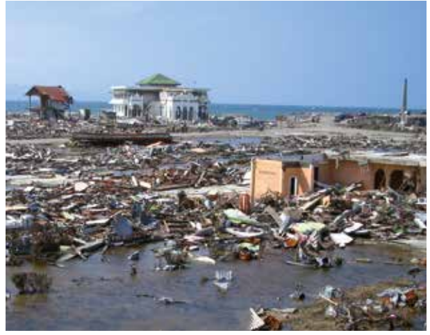
El tsunami del 26 de diciembre de 2004 destruyó la ciudad cercana a Banda Aceh (Indonesia) dejando sólo unas pocas estructuras en pie. Fotografía por cortesía de Yuichi Nishimura, Universidad de Hokkaido (Japón).
