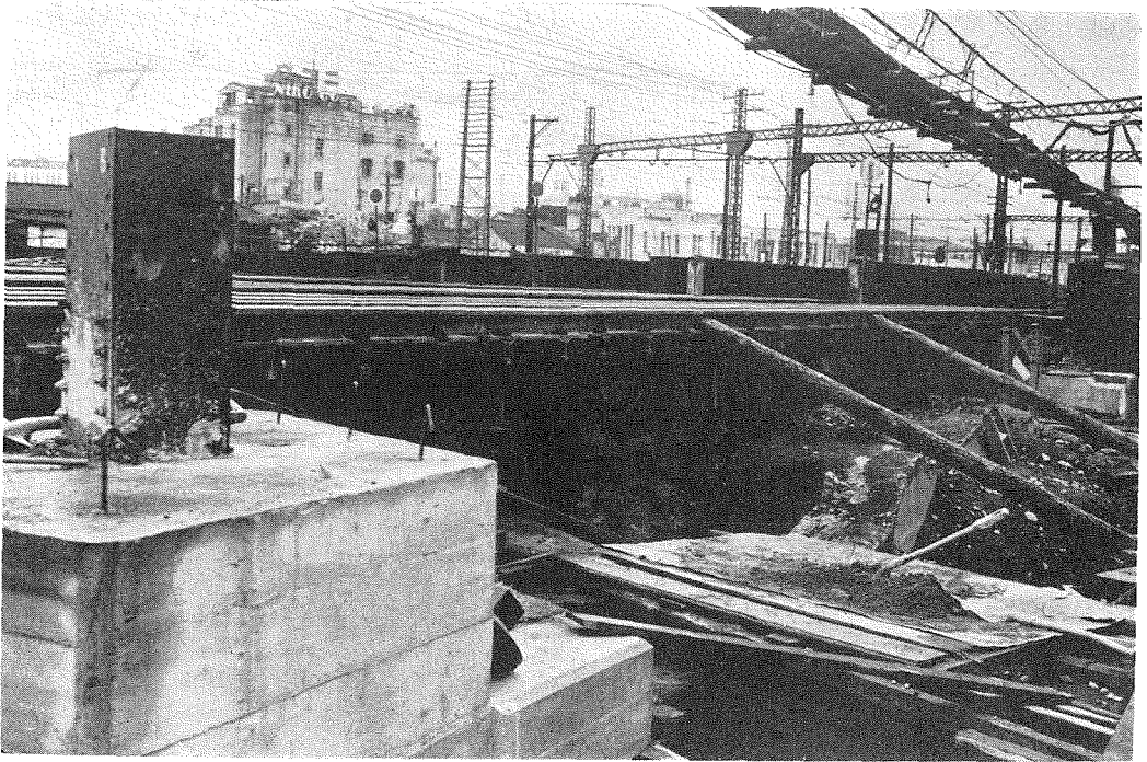
(5) 前頁写真の側面、吊桁で軌條を吊り之を枕木のサドルで受けつゝ線路下の掘鑿をなし、豫め組立てられてある鐵桁と交換するのである。写真の左方は完成した橋臺。
