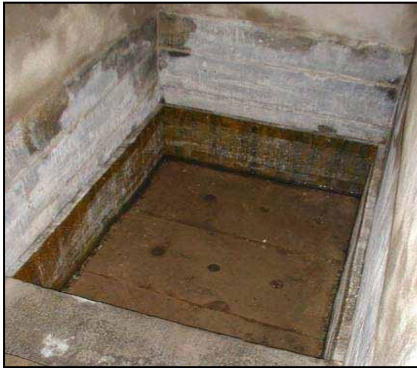
Abb. 8: Holzrahmen auf einem perforierten Holzboden in der 1989 freigelegten Mikwe aus dem frühen 18. Jahrhundert in Bischheim bei Straßburg. (Foto April 2004)
