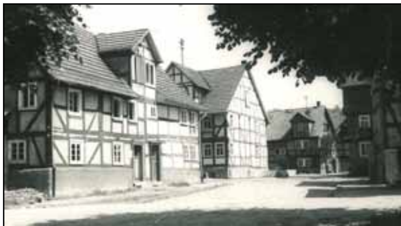
Abb. 40: Die Aufnahme zeigt die dem Mikwengebäude gegenüberliegende Häuserfront in der Brauhausstraße vor dem Abriss aufgrund des Baus der neuen Fuldastraße 1967-70.
