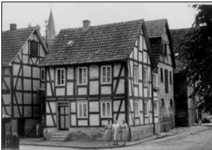
Abb. 41: Das Haus Brauhausstraße 2 in den 1960er Jahren, vor dem Anheben des Niveaus der Straße im Zuge des Baus der neuen Fuldabrücke 1967/70.
