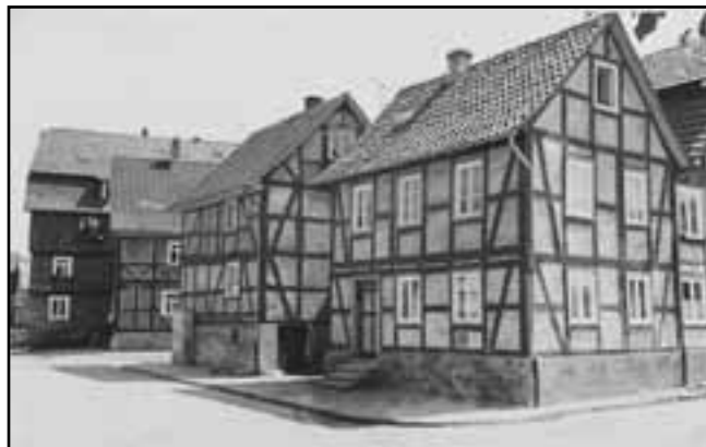
Abb. 38: Das Haus Brauhausstraße 2 (rechts im Bild), in dem sich die Rotenburger Mikwe befand, fügte sich harmonisch in das Ensemble der benachbarten Häuser.
