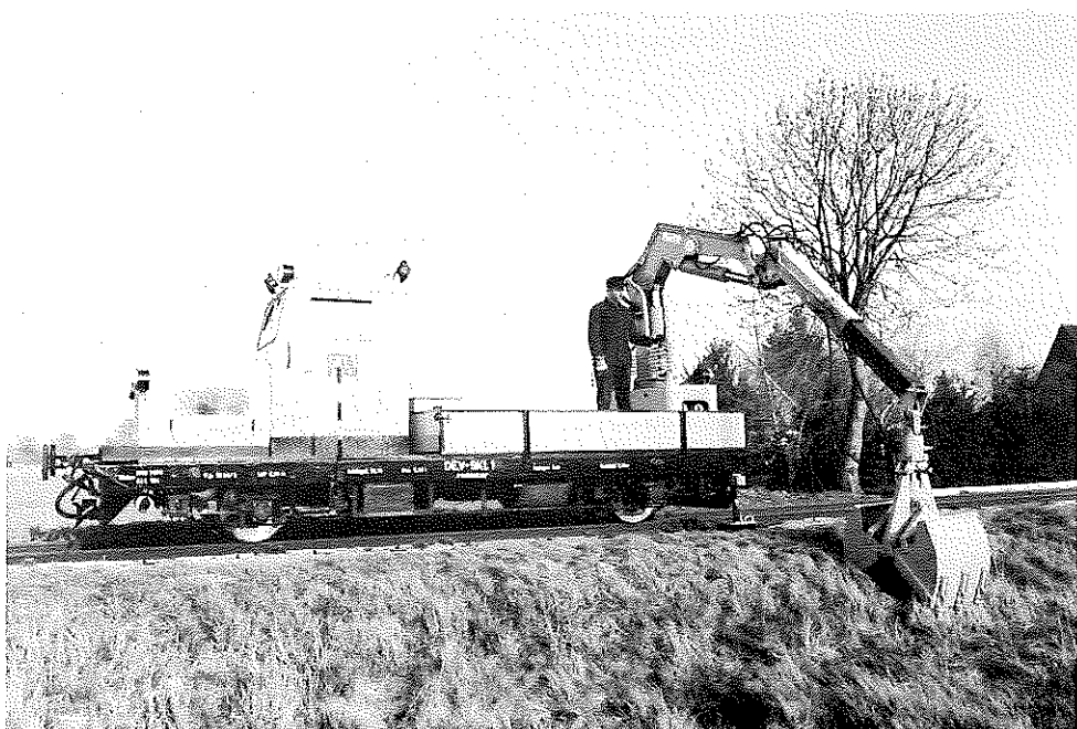
oben: »Friedhelm« im Einsatz beim Rotteneinsatz am 27. Januar 1990. Auch das Freihalten der Gräben gehört zur Rottentätigkeit. Foto: Heinz Esdorn
