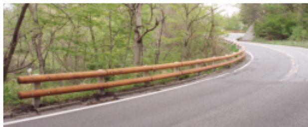
“温もりと美しさ”を感じさせる信州型木製ガードレールは、地元の建設業者・木材業者・県土木部の共同開発。鋼製と同じ耐久度を確保し、同額事業予算で5倍の地域雇用を実現。
