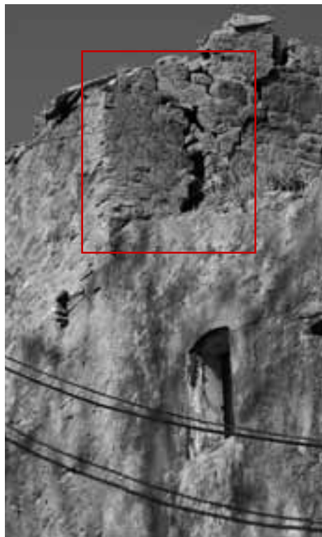
2 - dommage dû à l'affaissement des fondations au milieu d'un mur
