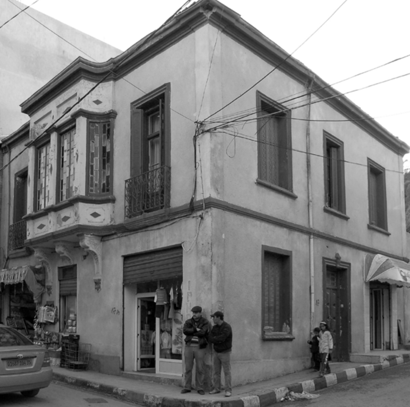
Maison coloniale implantée sur une parcelle d'angle donnant sur l'espace public le plus important de la ville européenne. Quelques solutions spécifiques de la maison traditionnelle de la casbah, comme le qbou, donnent lieu à des réinterprétations linguistiques et des hybridations avec le bow-window européen.
