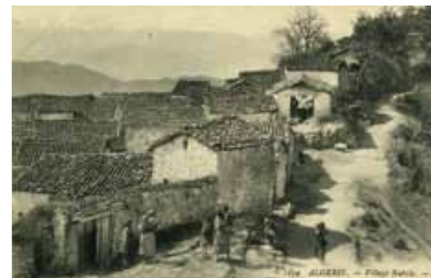
La typologie de la maison de Kabila, aujourd'hui presque disparue à Dellys, est une construction modeste qui se trouve à l'origine de la casbah actuelle.
