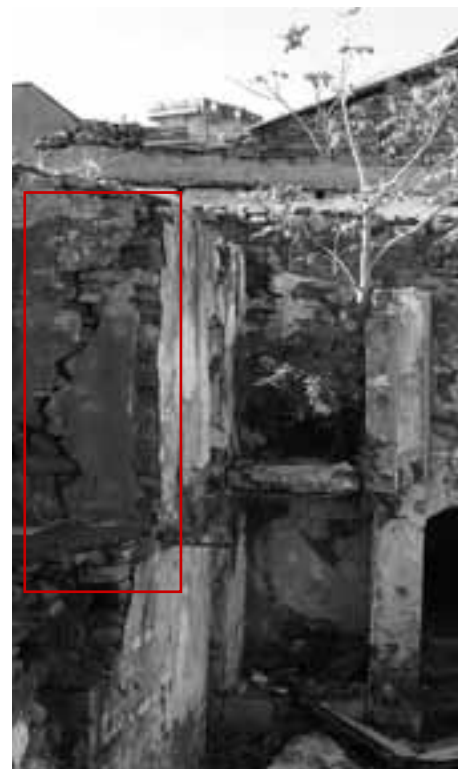
3 - dommage dû aux poussées transmises par la couverture
