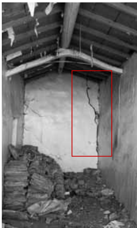
1 – dommage dû à l'affaissement des fondations au niveau de l'angle
