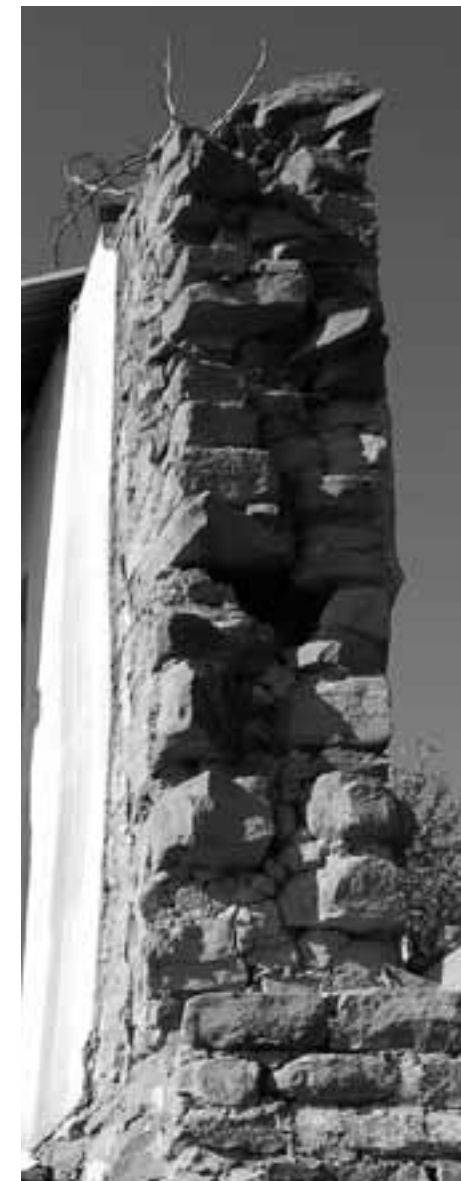
Dommage observable sur l'angle critique d'un mur en pierre dans la casbah de Dellys.
