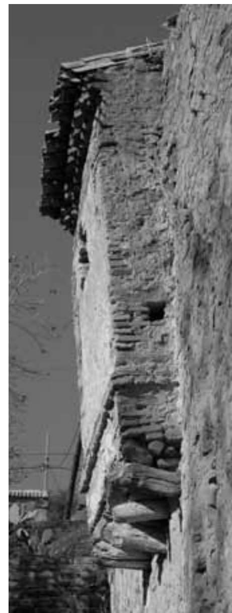
Vue latérale d'un qbou réalisé en maçonnerie de brique et structure de soutien en bois. A noter, le percement de forme carrée permettant d'observer la rue depuis l'intérieur du qbou.
