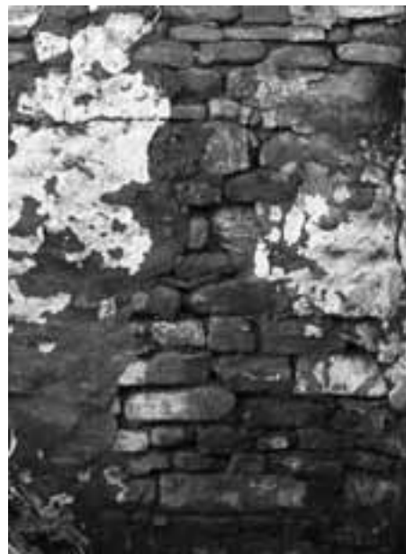
Dommage observable sur l'angle critique d'un mur en pierre dans la casbah de Dellys.
