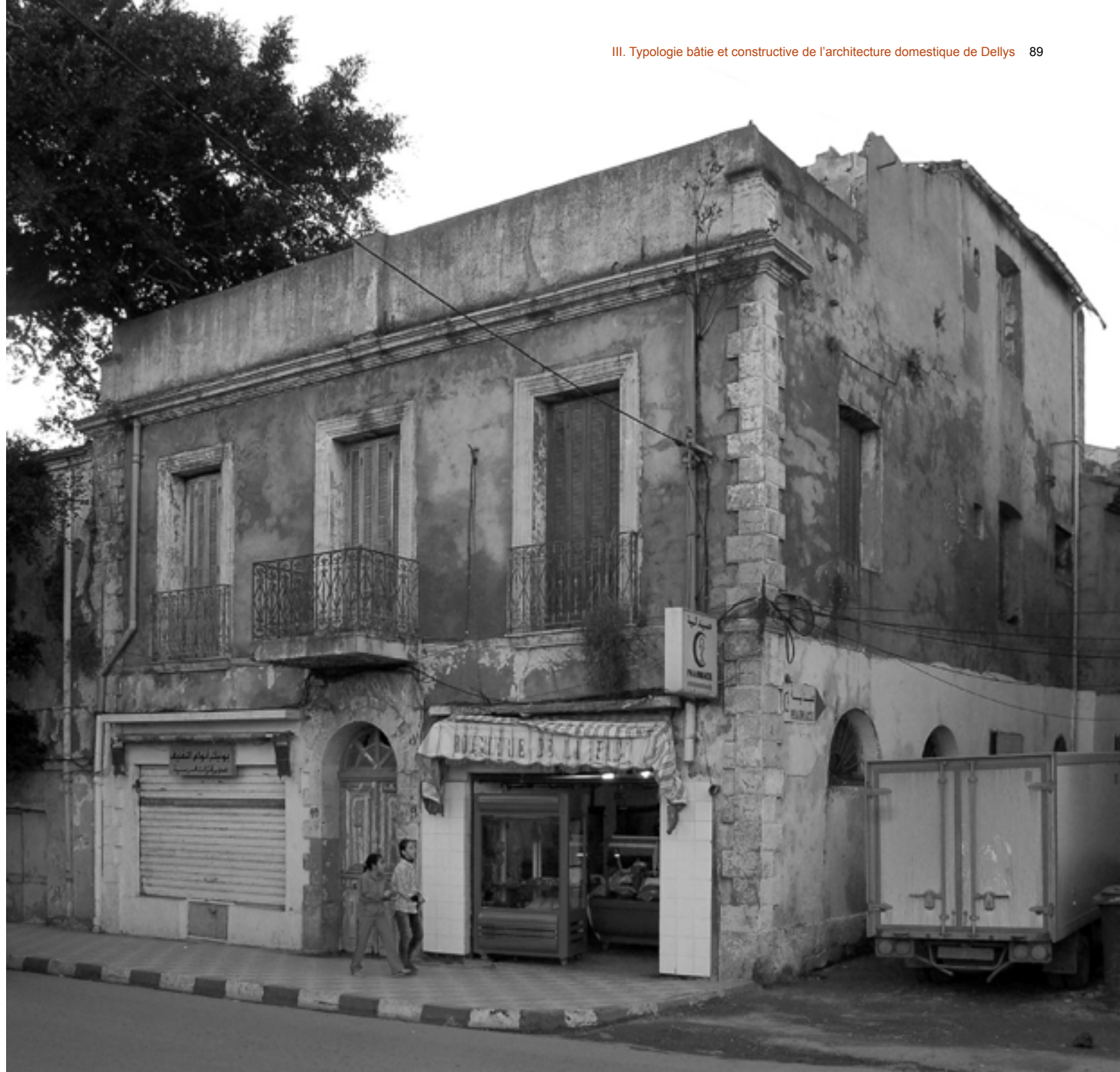
Maison coloniale le long du percement de la route nationale n°24, qui a divisé la casbah historique en deux parties. La maison se développe sur deux niveaux avec un corps bâti de double épaisseur correspondant au type principal mis en œuvre dans la ville coloniale. Le système d'ouverture du rez-de-chaussée a été significativement modifié pour accueillir une activité commerciale.
