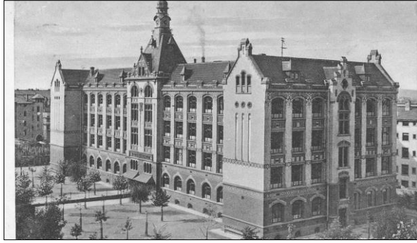
Mathildenschule, das Gebäude musste 1976 abgerissen werden
