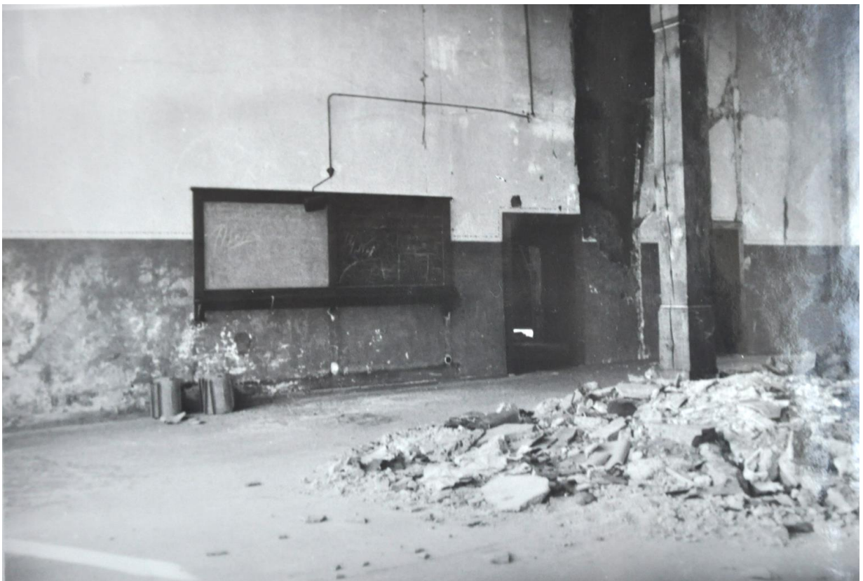
Zerstörungen im ehemaligen Zeichensaal im 4. Obergeschoss (Quelle: Stadtarchiv)
