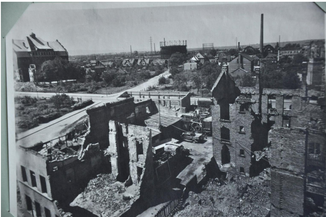
Die Schillerschule hinter den Ruinen in der Pirazzistraße ca. 1947 (Quelle: Stadtarchiv)
