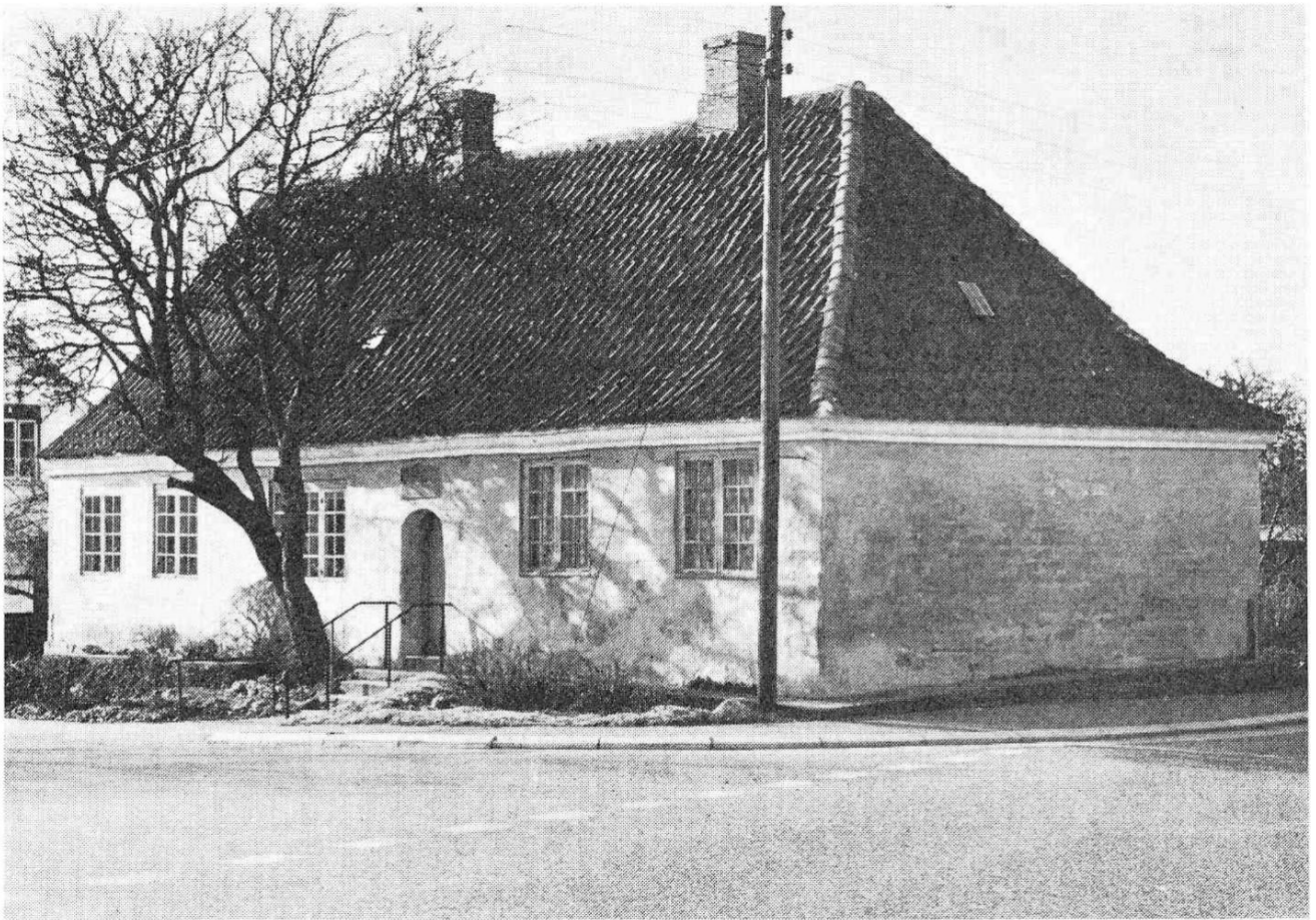
Kun få ændringer i tag, murværk, dør og vinduer. Oprindelig tavleplacering
