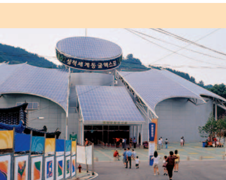
Photographie 14 : Le bâtiment en forme de chauve-souris de Cave Expo, abritant l'exposition des types de grottes et de préhistoire.
