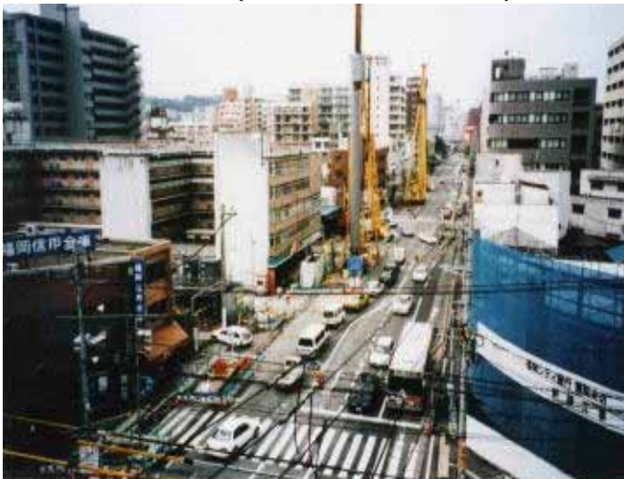
土留めの施工状況（柱列式地下連続壁工法）
