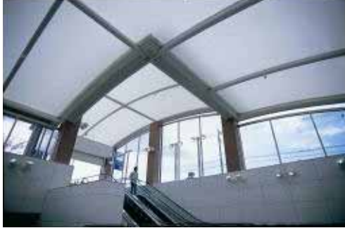
出入口の屋根に膜を使用 出入口（福大前駅）
