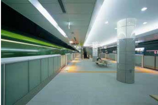
直線につくられたホーム
