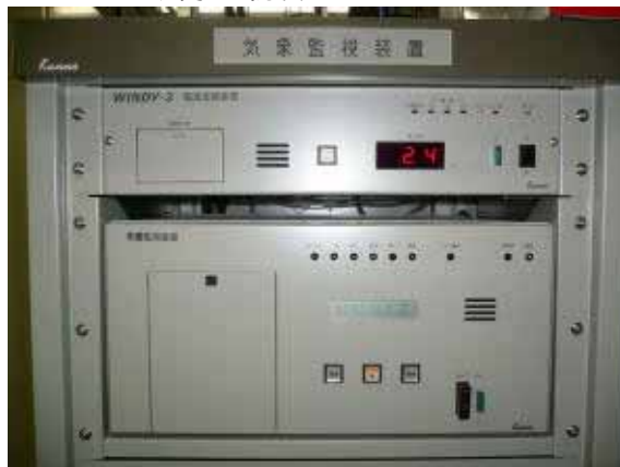
橋本車両基地に設置されている気象監視装置
