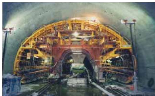
覆工コンクリート打設
