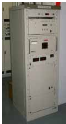
橋本車両基地に設置されている気象監視装置
