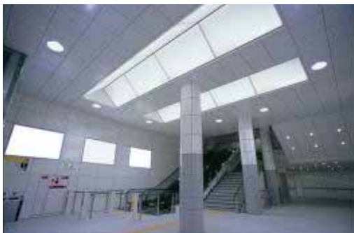
天井を利用した照明（光天井） コンコース（薬院駅）
