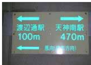
避難誘導標識
