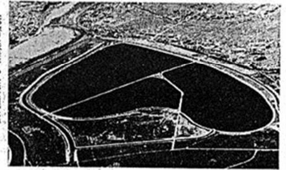
たまり水またわたり水にカビ臭発生 11月、野木町野木町リコンタから写す
