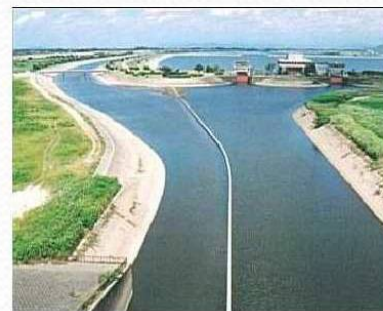
谷田川分離施設
