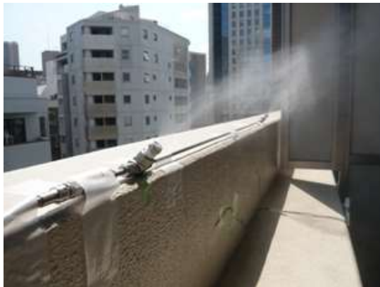
写真 3-2 室内方向噴霧（実験時）
