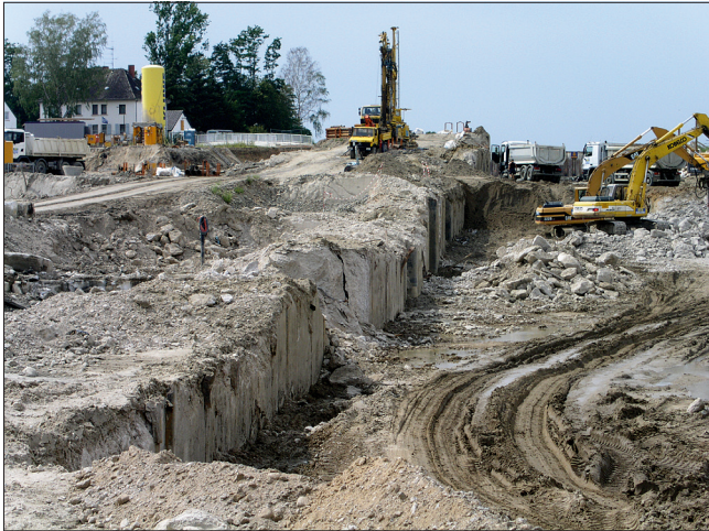
Bild 1: Abbruch Schleuse Sülfeld-Süd
