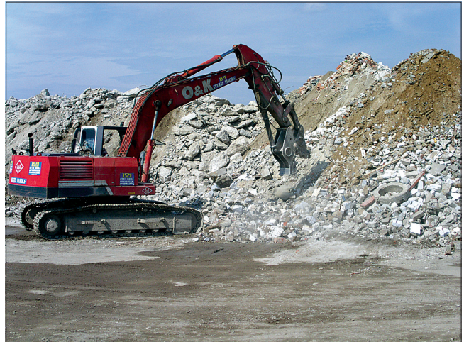
Bild 2: Grobaufbereitung des Betons
