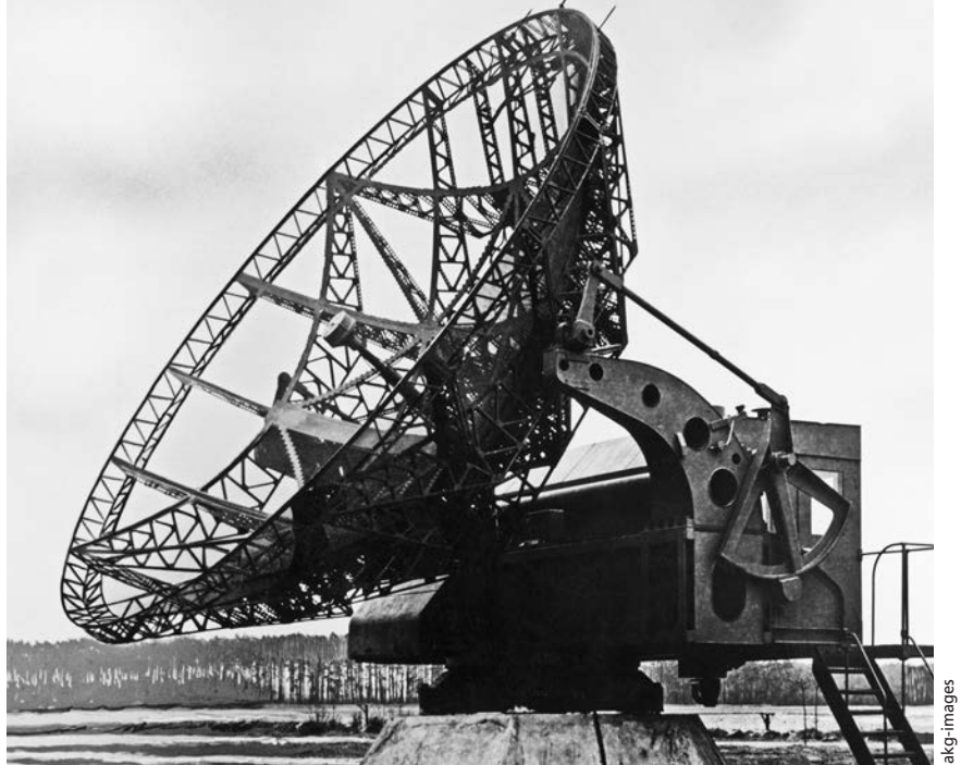
▲ Deutsche Radaranlage »Würzburg-Riese« (Gerät zur Ortung feindlicher Flugzeuge, hergestellt von Telefunken).
