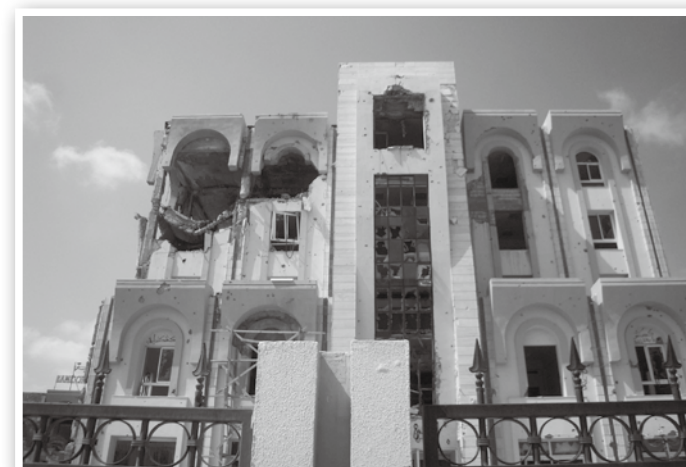
カダフィ軍による砲撃で破壊された建物。トリポリ近郊の都市ザウウィヤにて撮影。地方都市には、このように復旧の進んでいない所も多い。
