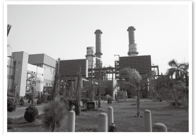
エジプト・カイロノース発電所
