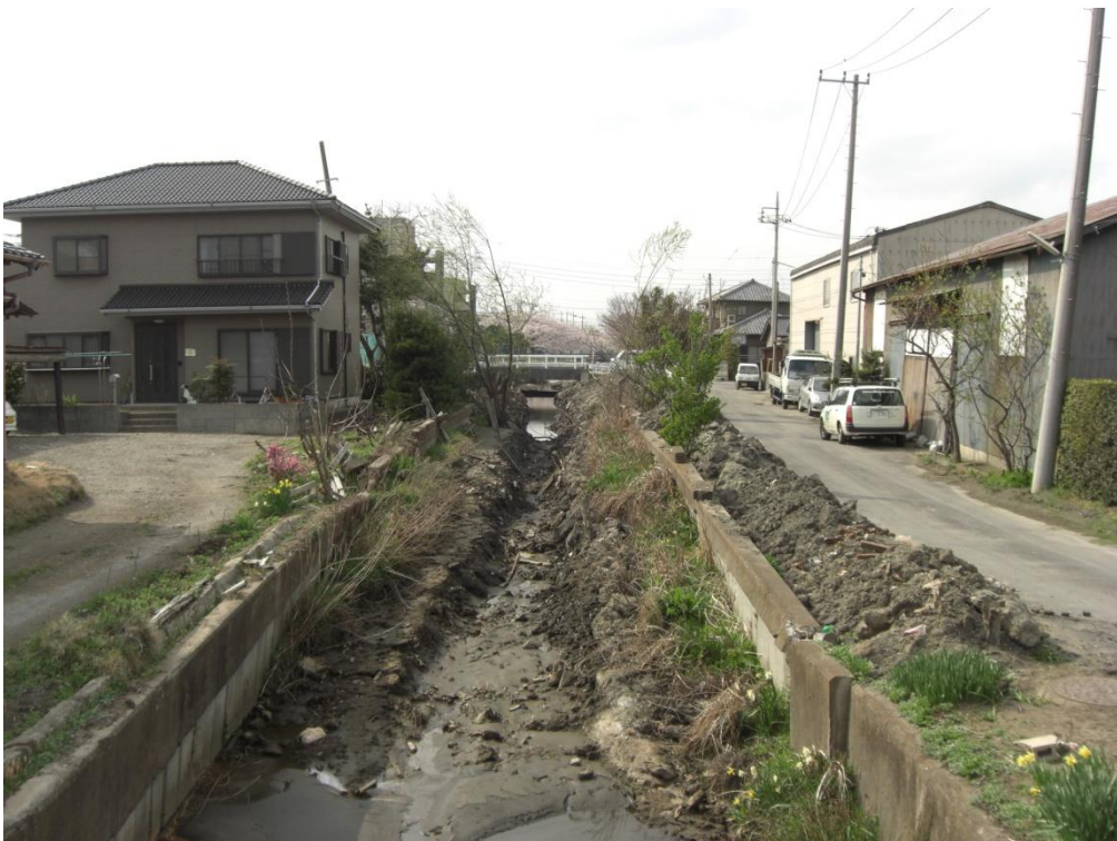
写真 17 噴砂によって埋没した十間川
