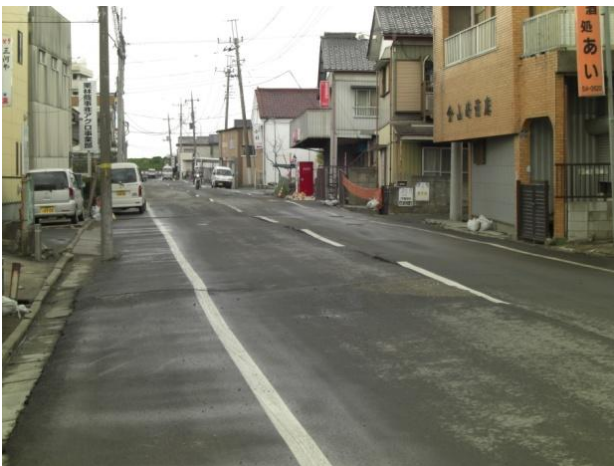
写真 14 粉名口付近における道路の波状変形(A)と電柱の傾斜(B)
