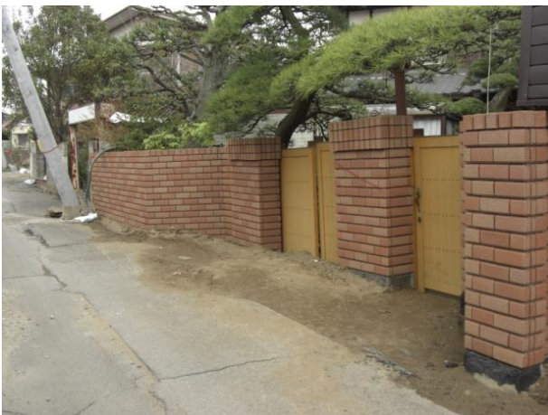
写真 15 水郷大橋町付近における構造物の沈下・傾斜と噴砂 (A, B)
