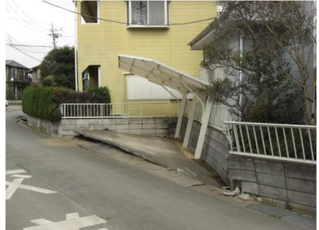
写真 15 水郷大橋町付近における構造物の沈下・傾斜と噴砂 (A, B)
