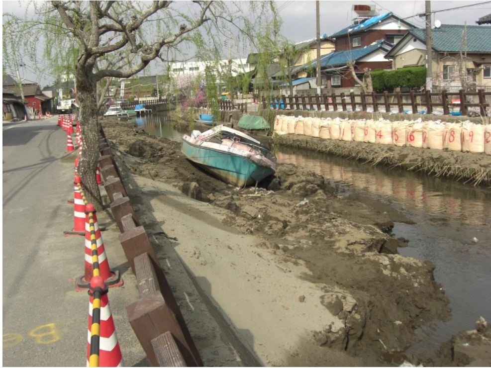
写真 18 噴砂によって埋没した小野川（右岸側から） 小型ボートが噴砂によって持ち上げられている。
