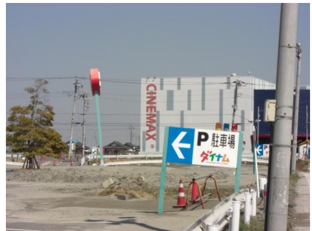
写真 8 西代地区大型商業施設周辺における看板の傾斜
