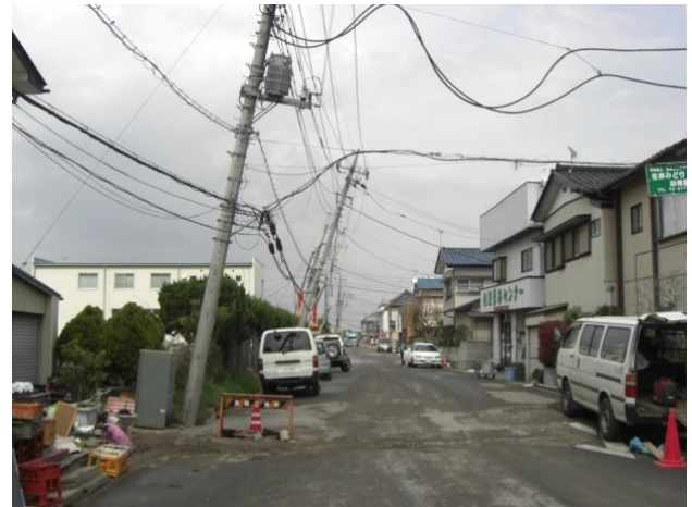
写真 14 粉名口付近における道路の波状変形(A)と電柱の傾斜(B)
