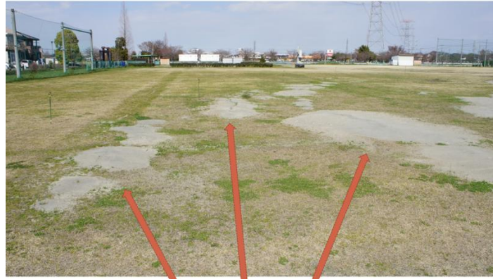
液状化して砂が噴いた跡
