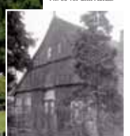
Schon vor 1973 entstehen auf der gegenüberliegenden Straßenseite auf den Grundstücken 30 und 38 zwei Mehrfamilienhäuser. Bild unten: Das alte Haus Nr. 30 vor dem Abriss.
