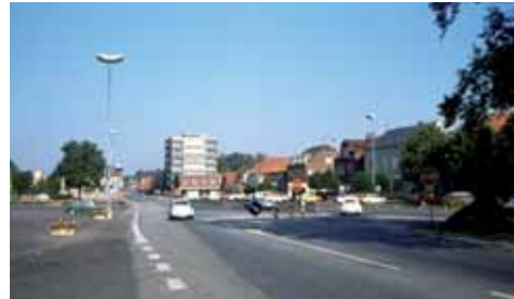
1973: Die neue städtebauliche Dominante, der Neubau der Sparkasse, überragt in seiner Sichtbetonbauweise den gesamten Platz. Doch damals diskutierte man in den städtischen Gremien kaum, ob sich ein Bau überhaupt entstehen soll. Mehr, höher, breiter! Zeitgeist, der lange über seine Zeit hinaus währt. Stadtarchivar Haas Finck notierte allerdings in seinen Untertagen schon 1971: „Seit Frühjahr wird gebaut, [...] um das 'Hochhaus', m.E. ein Schandstück, zu errichten.“
