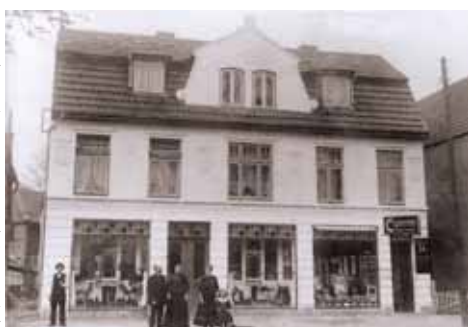
Landweg 23, das Hartkopfische Haus, ist bis zum Jahr 2000 das prägendste in dieser Häuserzeile. Dann wird es abgerissen mit dem Versprechen des Bauherren und des Architekten, die Fassade wieder herzustellen. Was aus dem Versprechen wurde, kann jeder selbst sehen.
