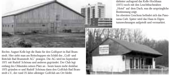
Rechts: August Kelle legt die Basis für den Golfplatz in Bad Bramstedt. Hier sieht man am Reitschuppen ein Schild des „Golf- und Reithaus Bad Bramstedt AG“ prangen. Die AG wird im September 1971 mit Rudolf Schönau und anderen gegründet. Der Club legt entlang des Ohlthales seinen Platz an - heute kaum mehr denkbar. 1975 gründen er und Rudolf Schönau dann den Golfclub Bad Bramstedt e.V., der rund 25 Jahre alleiniger Golfclub am Ort bleibt.
