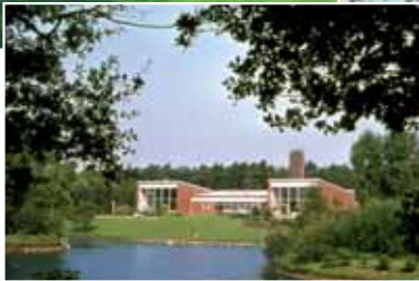
Das „Haus am Teich“ bildet das Zentrum für Gruppengymnastik, ob trocken oder im Wasser, ob in Sole oder Normwasser. Massagen und Ergotherapie sind auch mit untergebracht. Nun (2010) wird das Haus seine Dienste bald erledigt haben und wahrscheinlich abgerissen.
