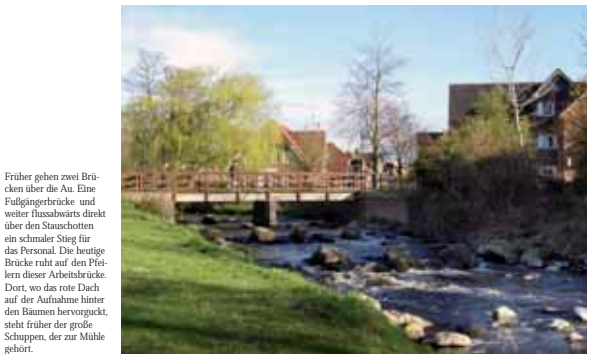
Früher gehen zwei Brücken über die Au. Eine Fußgängerbrücke und weiter flussabwärts direkt über den Stauschotten ein schmaler Stieg für das Personal. Die heutige Brücke ruht auf den Pfeilern dieser Arbeitsbrücke. Dort, wo das Dach auf der Aufnahme hinter den Bäumen hervorguckt, steht früher der große Schuppen, der zur Mühle gehört.
