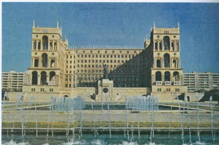
Şəkil 41. Hökumət evinin binası.
