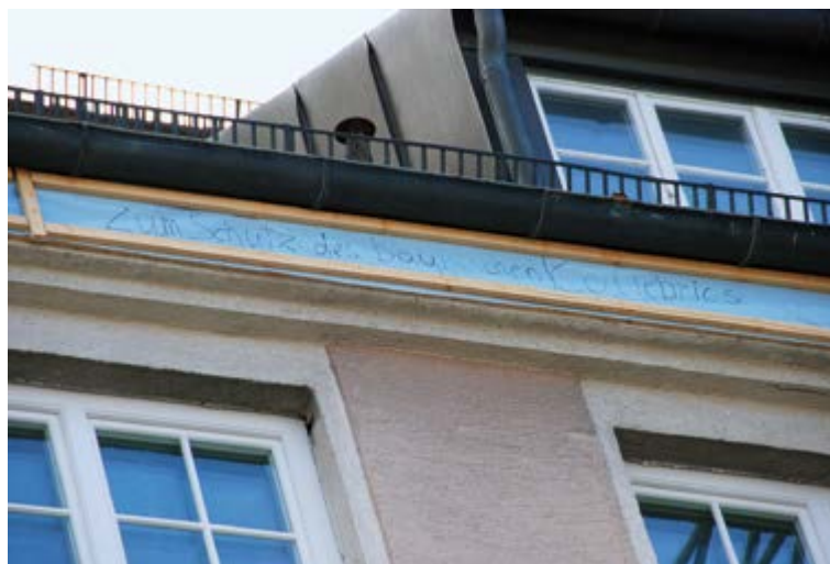
Abb. 2: Wer Gebäudebrütern den Zugang zu ihren Quartieren verwehrt, braucht dazu eine Genehmigung der Höheren Naturschutzbehörde. Die Aussperrung muss unbedingt frühzeitig vor der Rückkehr der Tiere erfolgen und nach Sanierungsende wieder entfernt werden. In dem Beispiel wurden die Zugänge zu den Brutplätzen, hinter der Regenrinne liegend, mit Holzlatte und einer Folie für die Dauer der Baumaßnahme verschlossen (Foto: Sylvia Weber).
