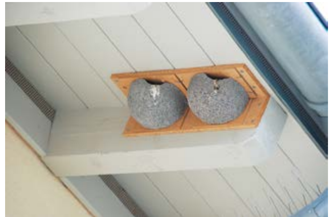
Abb. 6: Wurden Schwalbennester entfernt, kann man mit künstlichen Nisthilfen Ersatz schaffen und gleichzeitig unerwünschte Verschmutzungen eindämmen. Beispielsweise bleibt die Fassade sauber, wenn die Nisthilfen an den Dachsparren angebracht werden (Foto: Sylvia Weber).
