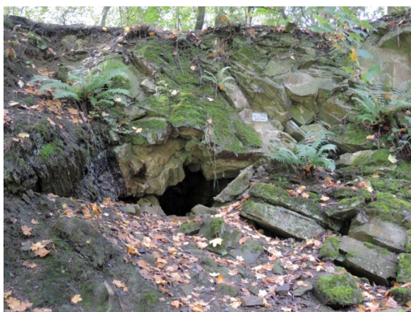
Abb. 25: Verstürzte Abbaustrecke von Flöz Dickebank (T. KASIELKE).
