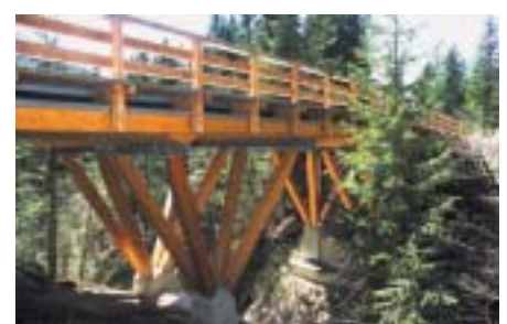
Bild 16: Holzbrücke, auch für den Schwerlastverkehr zugelassen.
