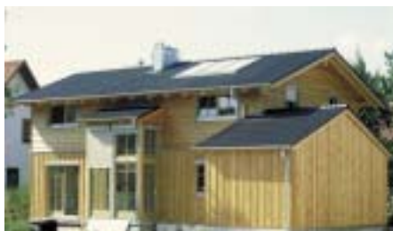
Bild 17: Außenverschalung eines Holzhauses (Niedrigenergiehaus) aus unbehandeltem Lärchenholz.
