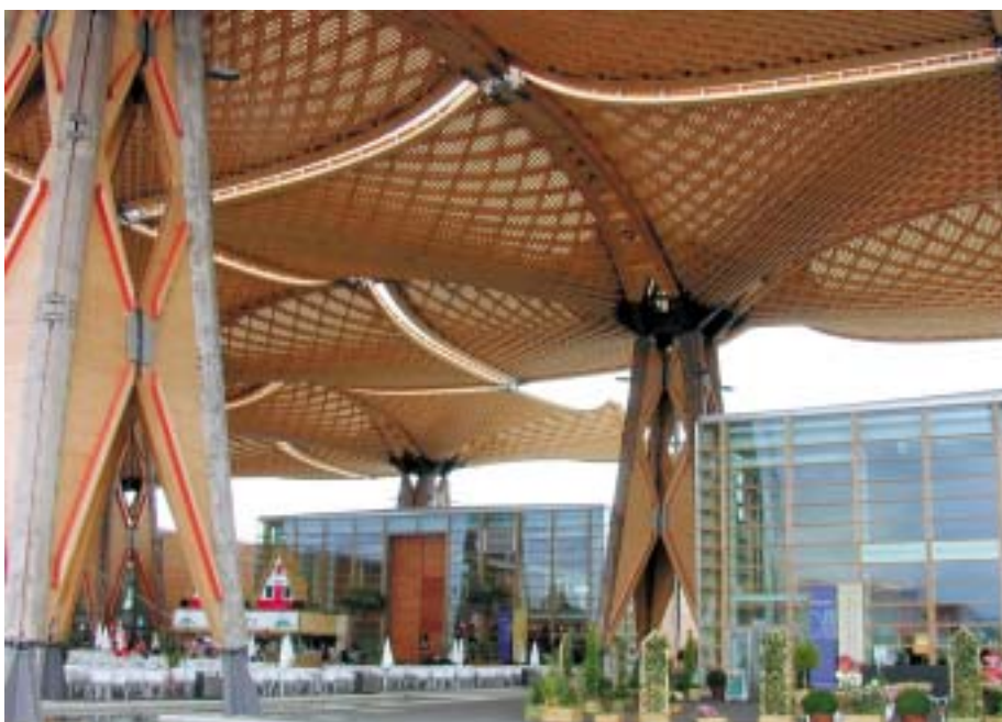
Bild 11: Das EXPO-Dach: Symbol für das ökologische, aber auch technische Potenzial von Holz.
