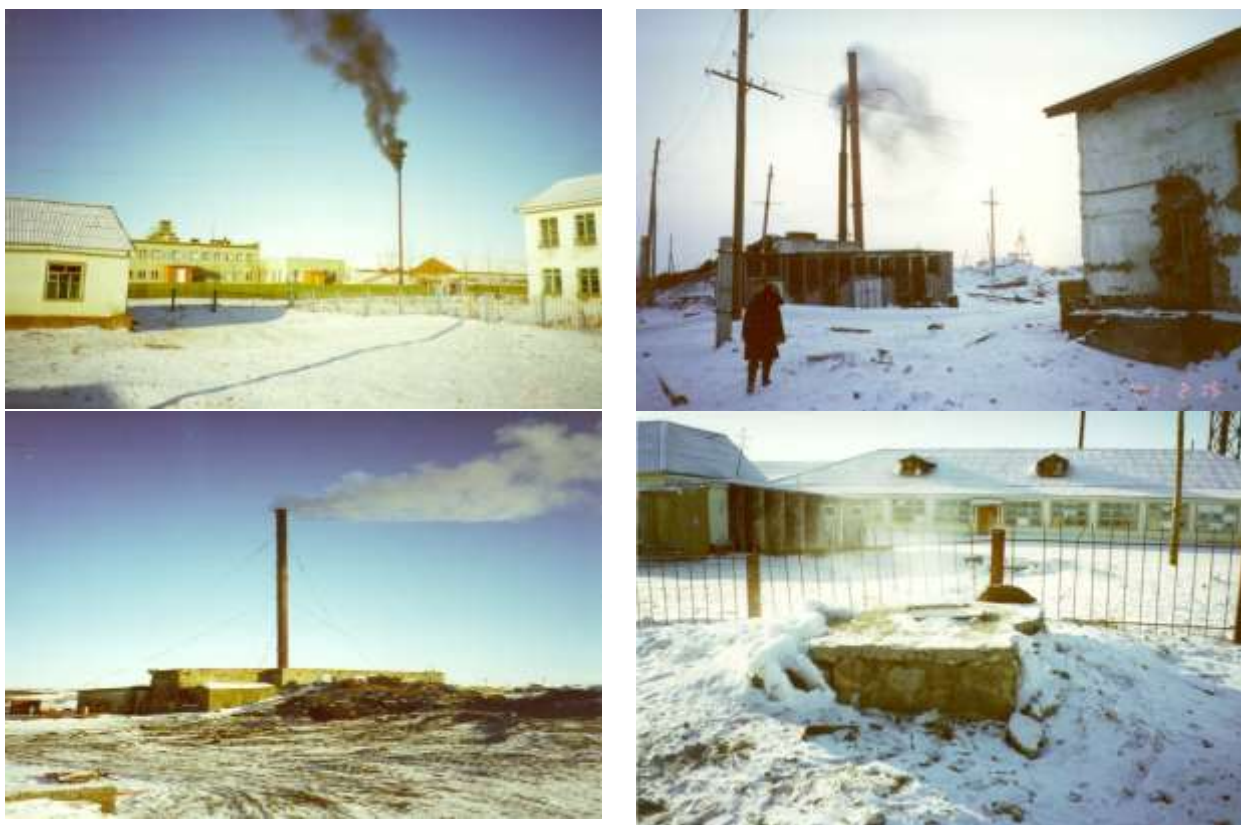
Рисунок 2.3 Типовые примеры котельных и состояния тепловых сетей в поселках с изолированными системами теплоснабжения (Магаданская область)
