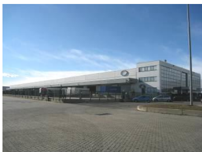
Logistics at the Interporto SITO
