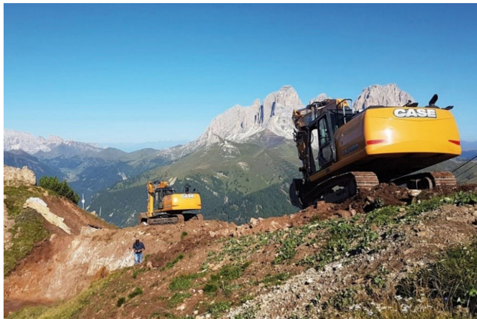
Figura 7. Modellazione del terreno per la preparazione delle piste in Val di Fassa
