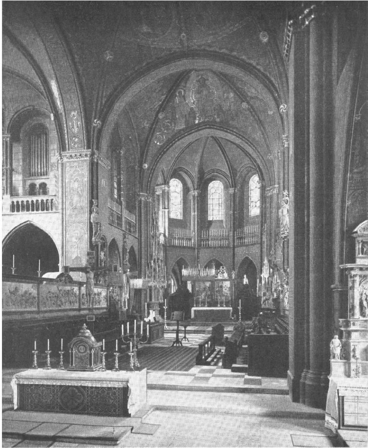
Abb. 14. Innenansicht des Domes zu Münster nach Abbruch des Lettners und Ausmalung im 19. Jh.
