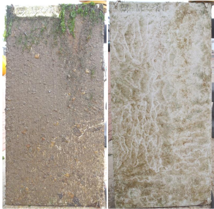
Abb. 48: Panadur Testplatte bei der ersten Inspektion vor und nach der Reinigung mittels Caviblaster.
