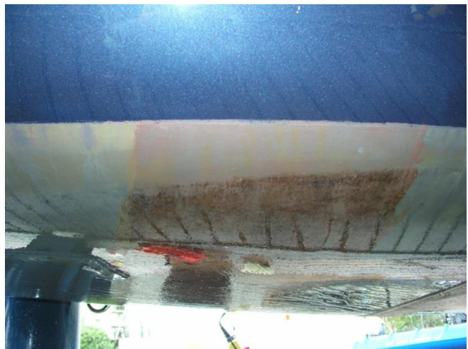
Abb. 111: Endinspektion am 07.11.2013, Rumpf der Sawatzki nach der Reinigung mit Hochdruckwascher. Der Biofilm auf der unbeschichteten Fläche ist persistent
