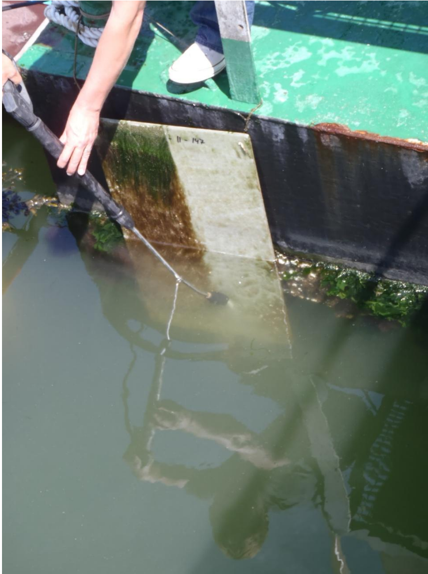
Abb. 14: Kärcher Hochdrucksystem mit Dreckfräse und starrem Griff.
