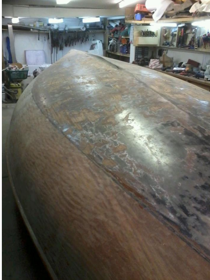
Abb. 24: Entfernung aller alten Antifoulingbeschichtungen auf dem Rumpf des Jollenkreuzers El Gordito (Quelle: Segler-Verein Wakenitz e.V.).
