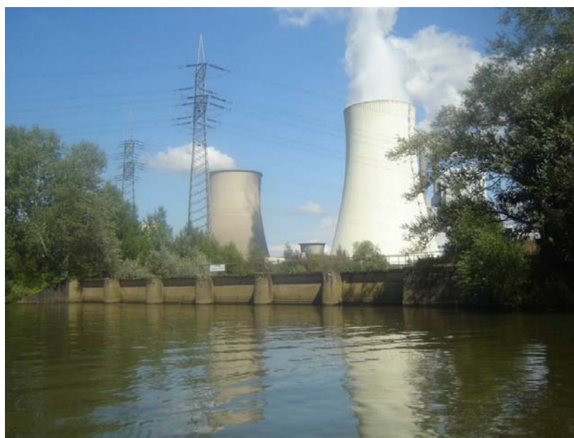
Abbildung 2.2-1 Blick von der Probenahmestellen P 2 zum Kraftwerk Staudinger (23.08.2007)
