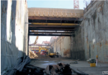
Behelfsbrücken über der Baustelle
