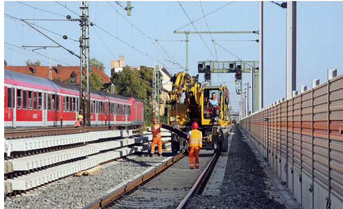
Die Lärmkartierung umfasst auch die Lärmwirkungen von Haupteisenbahnstrecken.
