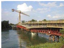
Die neue Brücke bei Laufenburg
